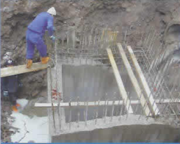
Öğretmenevi Önünde Yapılan Kanalizasyon Çalışması
