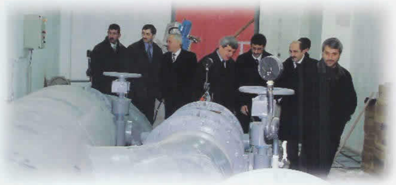
P-3 Pompa İstasyonu
