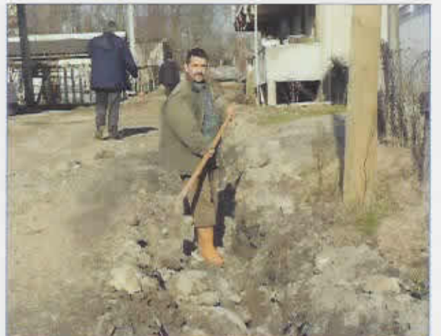
Acısu Yavuz Sultan Selim Mah. Kanal Çalışması
