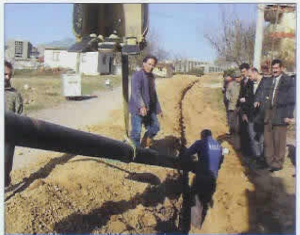
Kabaoglu Divanı İçmesuyu İnşaatı Çalışmaları Esnasında
