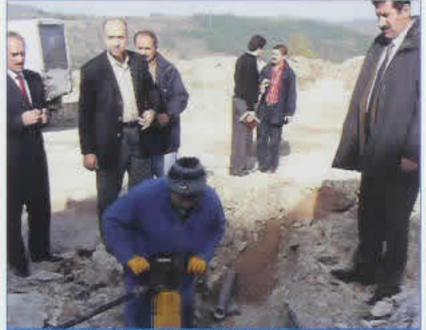
Su ve Kanal İşletmeleri Daire Başkanımız Aytekin KAHRAMAN Bey Sarıyahçe Belediyesi Gültepe Şantiyesi İçmesuyu Çalışmasını Kontrol Ederken
