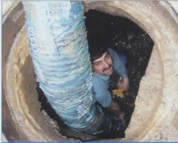
Tavşantepe - Türbeyayın Ayrım Vanası Arıza Çalışması Yapılırken
