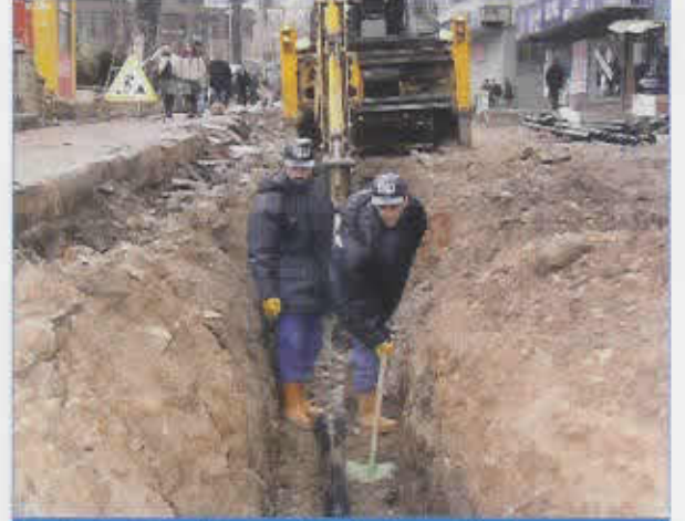
Fevziye Camii Çevre Düzenleme İşine Ait Altyapı Çalışmaları
