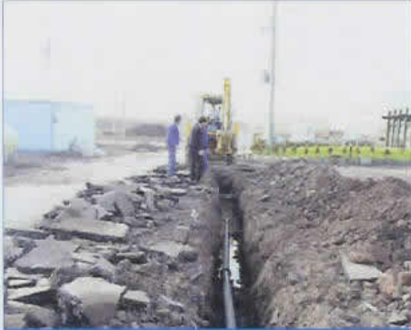
Yahya Kaptan Mahallesi İçmesuyu Çalışması
