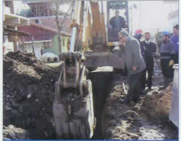
Kollar Stadyumu ve Civan Kanal Çalışmaları
