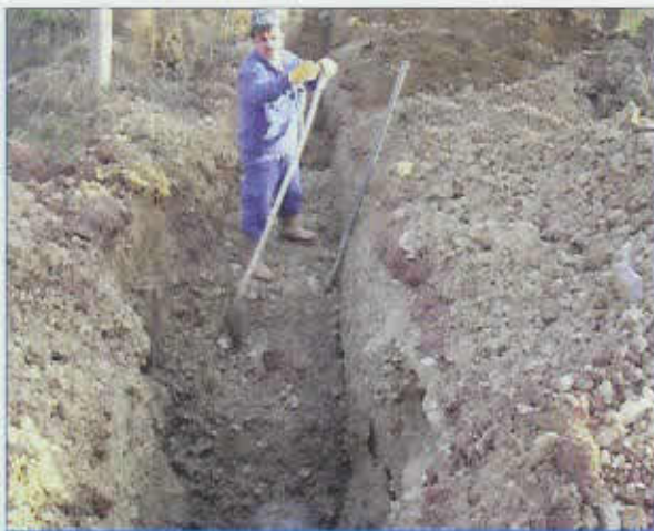
Yeşilova Mah. Kanal Çalışmaları Yapılırken
