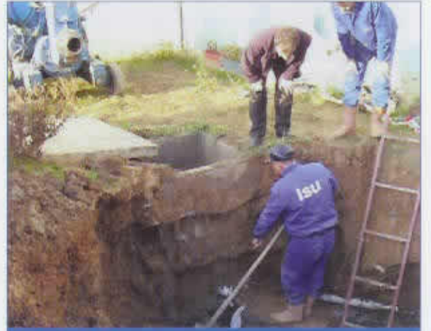
Kollar Stadyumu ve Çevresi Kanal Çalışmaları
