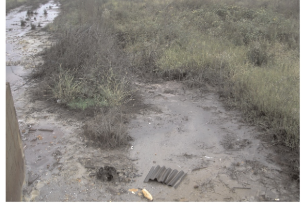
Başiskele Mevkii Kimya Sanayi Asitli Suların Alıcı Ortama Deşarjı
