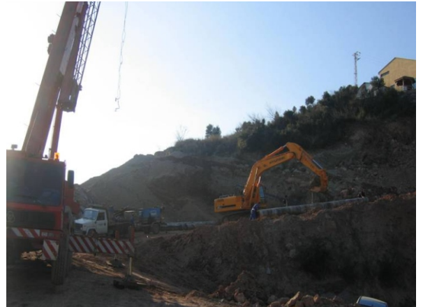
Hereke su deposu yanında yapılan 200 m uzunluğunda 600 mm çelik hattan Hereke deplase çalışması.
