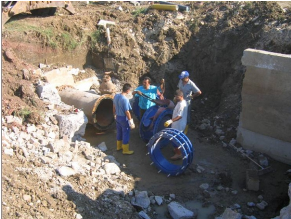
Seka Sapanca isale hattı Ø 800 mm pik hattan Sabancı ENERJİSA ve Entek fabrikalarına verilecek suyun bağlantı çalışmaları.
