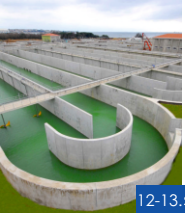
Gebze Atıksu Arıtma Tesisi
