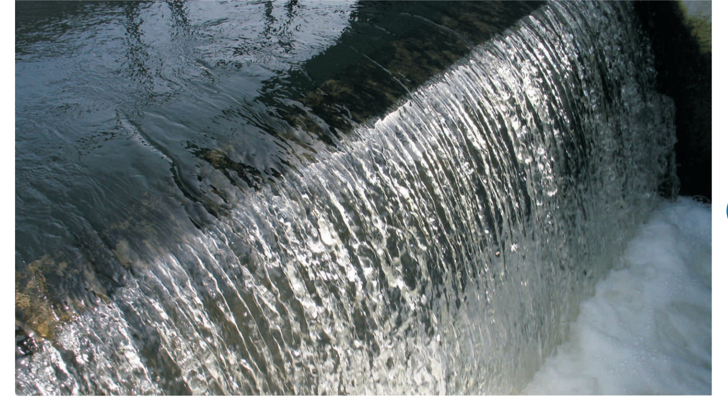
Körfez Atıksu Arıtma Tesisi
