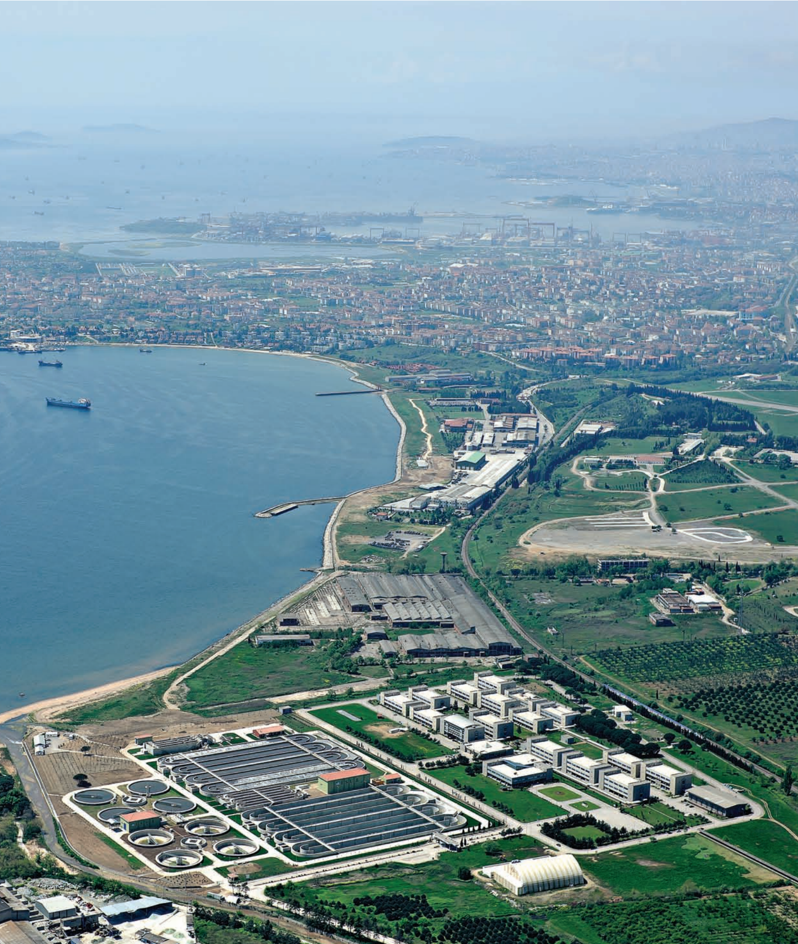
Gebze Atık Su Arıtma Tesisi
