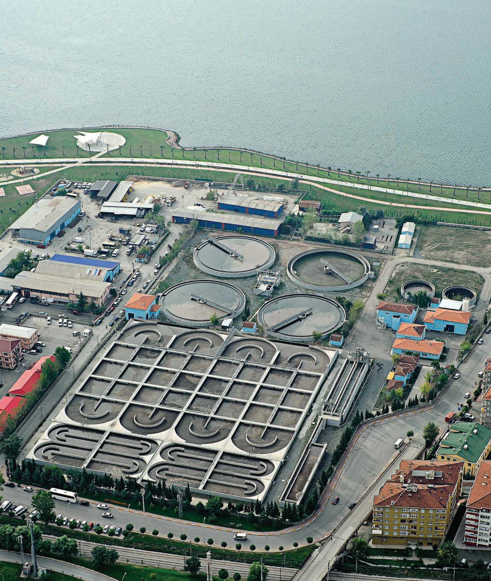
Plajolu Atık Su Arıtma Tesisi
