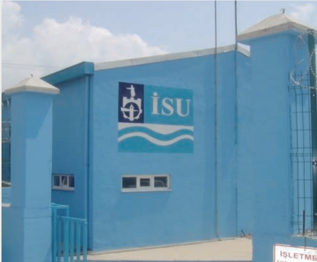
Sapanca Terfi İstasyonu
