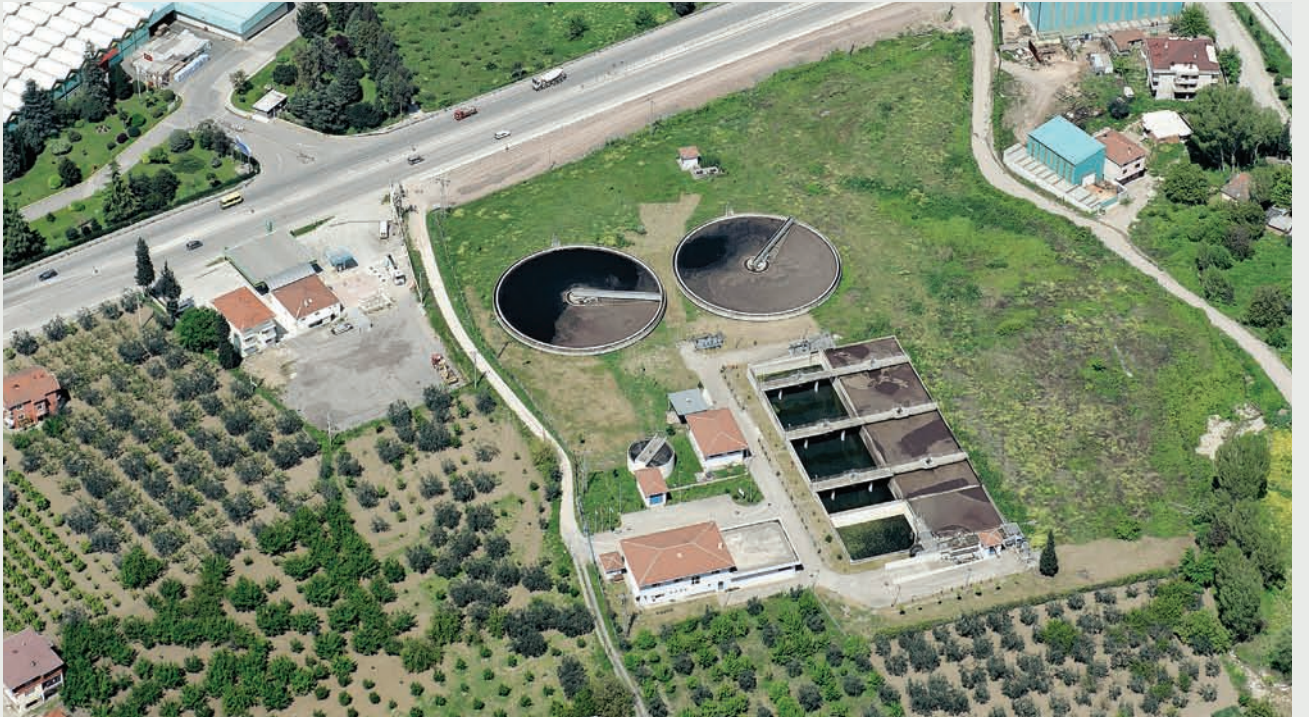
Karamürsel Atık Su Arıtma Tesisi
