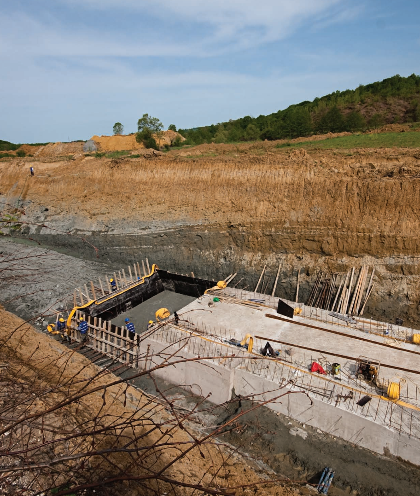
Namazgah Barajı Kondüvi Temel Betonı Atılması
