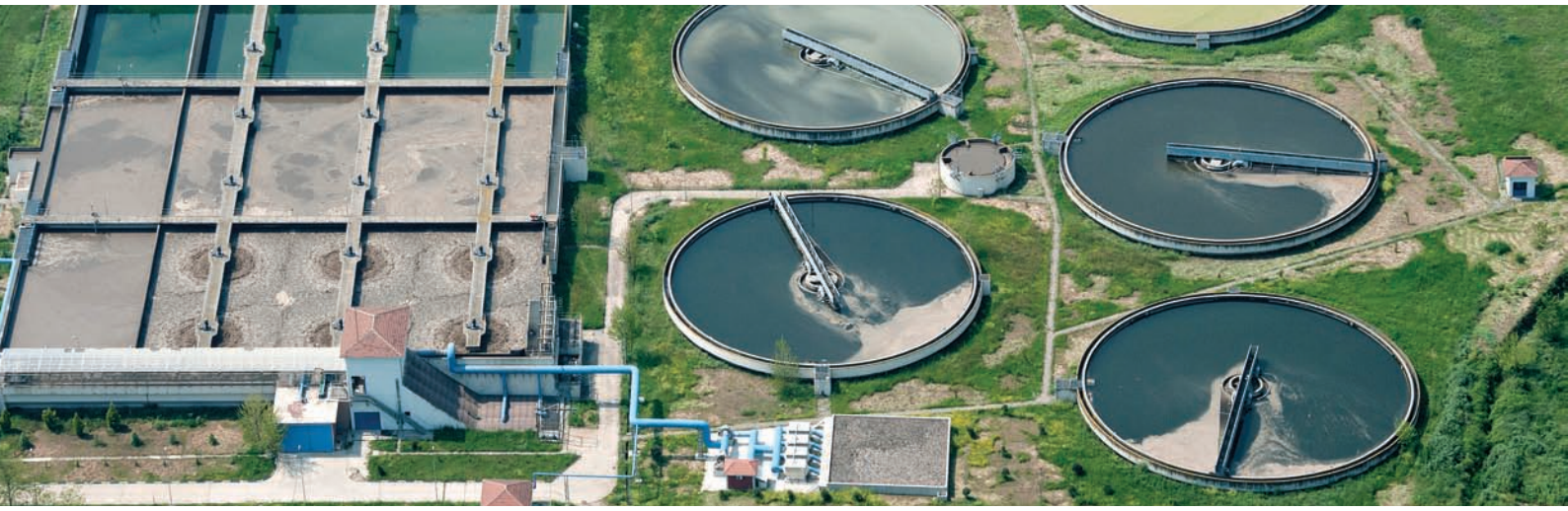
Kullar Evsel Atık Su Arıtma Tesisi
