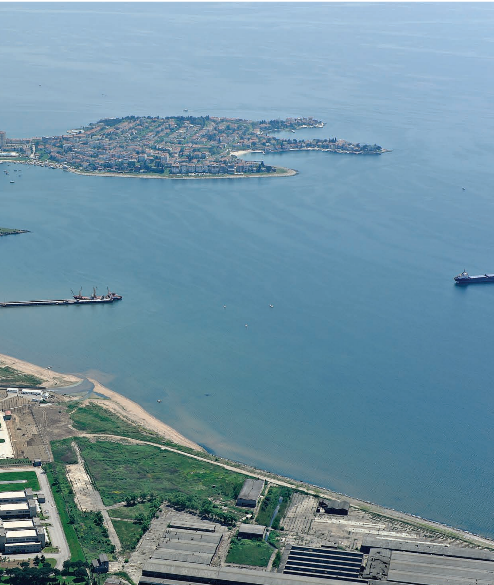
Gebze Atık Su Arıtma Tesisi
