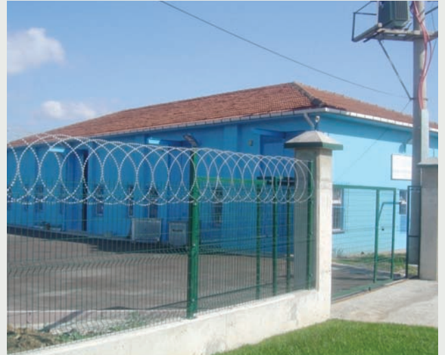
Bahçecik Terfi İstasyonu
