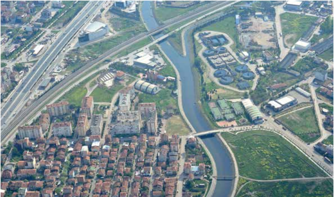
42 Evler Atık Su Arıtma Tesisi
