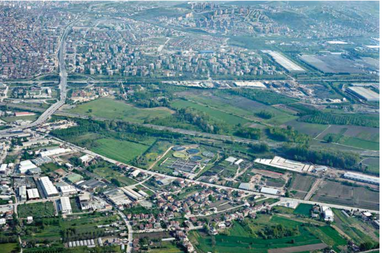
Kullar Atık Su Arıtma Tesisi
