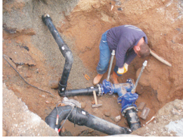
Serdar M. Karaca S. Ø250 hat vana montajı yapılmıştır. Kuruçeşme Doğan S. yeni şebeke çalışması yapılmıştır.
